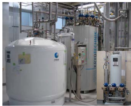
【富山大学 研究推進機構 極低温量子科学施設 ヘリウム液化システム】
